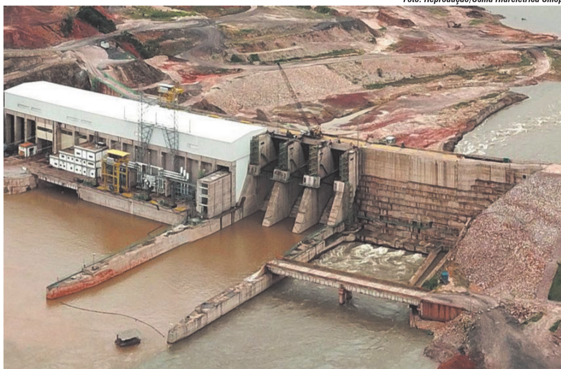
Foto: Reprodução/Usina Hidrelétrica Sinop
